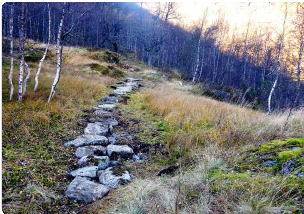
Frå Kilen og opp mot Storhaug er stien no utbetra. Her er eit blautt parti hellelagt.
