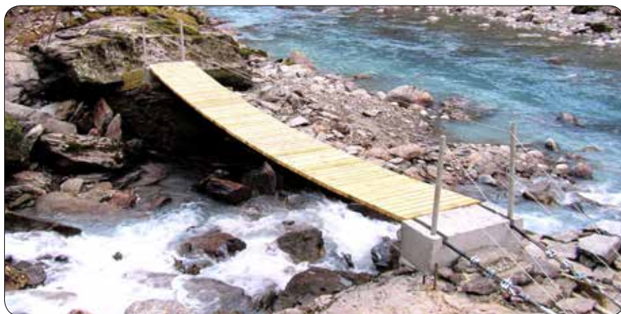
Ny bru over Nobbelvi i Mørkridsdalen. Tilkomsten ned til brua er også utbetra.
